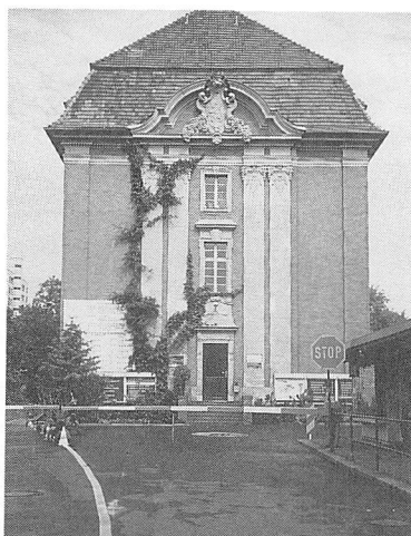
写真4 戦災を免れ、現在も残って いるモアビット病院の建物の一つ。 元は看護婦宿舎で、現在は管理棟(著 者撮影)
